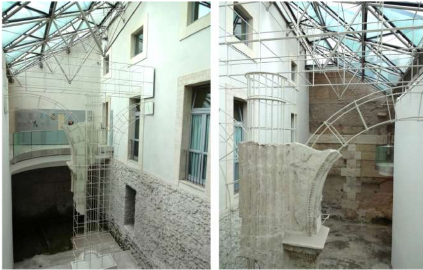
Pilastro del portico ricostruito con un traliccio metallico.
